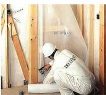
透湿シート張り
